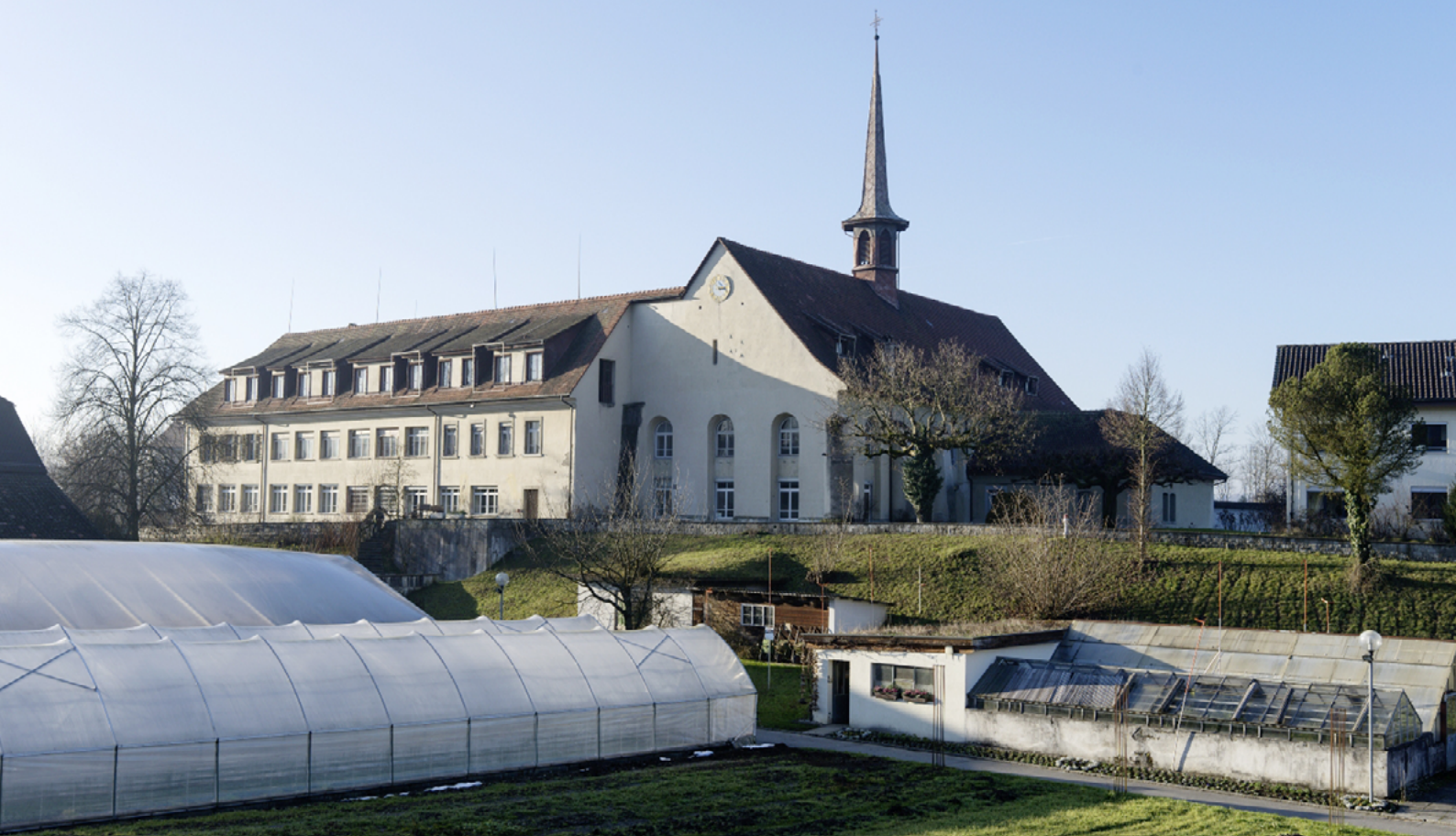
Aussenansicht des ehemaligen Klosters Rathausen, kurz vor der Renovation. Fotografie: Jean-Pierre Grüter, Luzern, 2015. Archiv SSBL.
